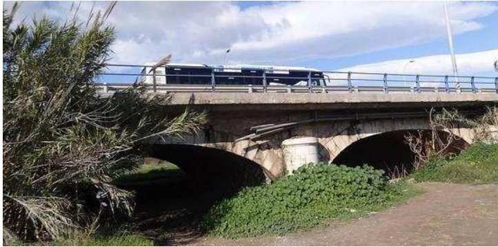
El puente de la N-340 ejerce como una barrera en el encauzamiento del Guadalhorce. / Fernando González
