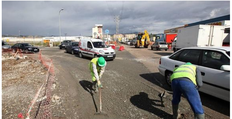
Operarios trabajan en la retirada de barro y lodo en el polígono del Guadalhorce en 2010. / sur
