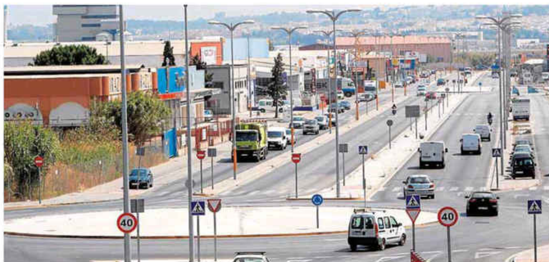
El desdoblamiento de la carretera Azucarera-Intelhorce ha mejorado considerablemente los accesos al Guadalhorce. :: SUR
