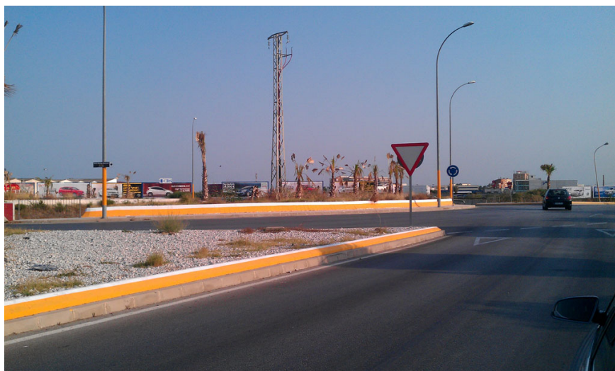
Trabajos de pintura para mejoras varias zonas.
