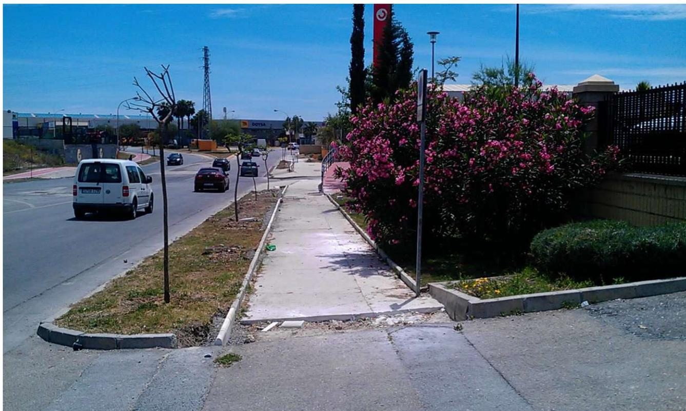
Se han contruido 280 m2 de acerado y 280 ml de bordillos de jardín en la Cl. Cesar Vallejo, entando en construcción los bordillos exteriores para dar por finalizado ese tramo.
